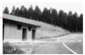
東側駐車場・トイレ
