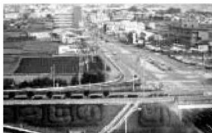
国道57号線大津バイパス
