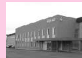
完成した(株)東洋新薬熊本工場
