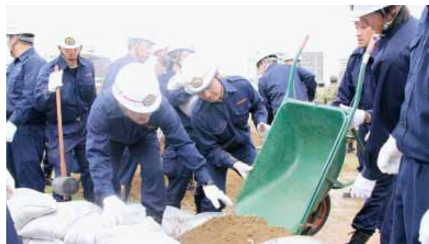
正確に素早く「月の輪工」を組み上げる消防団員たち
