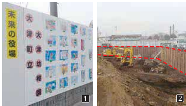
1 工事現場東側の仮囲い 2 山留め工事の様子(点線部分が山留め)
