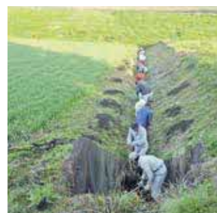
水路の泥上げ作業
