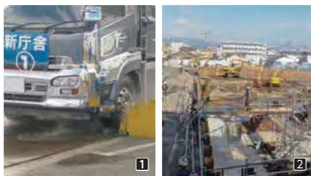
1建設現場を出る際は自動洗浄装置でタイヤを洗浄します 2地中基礎工事
