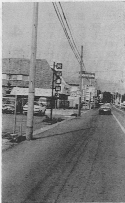
道路左側に埋設します (片山歯科前)
