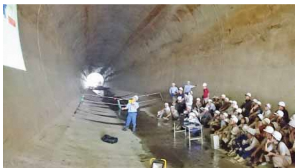
仮排水路トンネル内部の壁にプロジェクターで画像が映し出され、ダム工事の概要について説明が行われました
