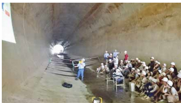
仮排水路トンネル内部の壁にプロジェクターで画像が映し出され、ダム工事の概要について説明が行われました
