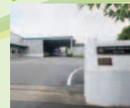
熊本工場の外観
