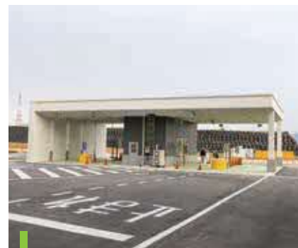
ゴミの搬入時に重さを測る計量器。屋根には太陽光パネルも設置されている
