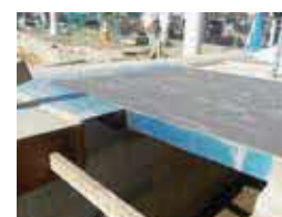
入口に設置された免震工スパンションジョイント
