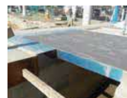
入口に設置された免震工キスパンションジョイント
