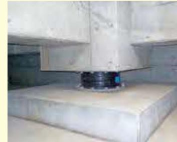
建物と基盤との間に免震装置を設置し、地盤と切り離すことで建物に地震の揺れを直接伝えない構造
