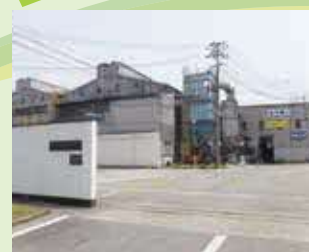
熊本工場の外観
