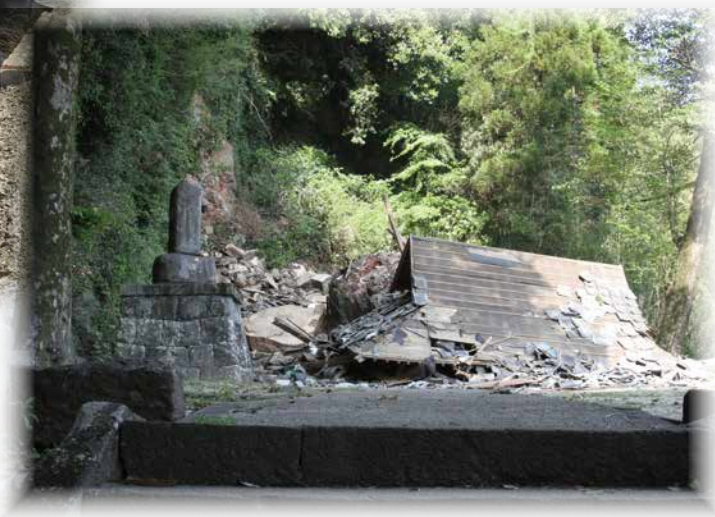
瀬田神社の被災状況（当時）
