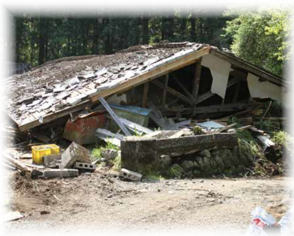
建物・宅盤の被災状況（当時）
