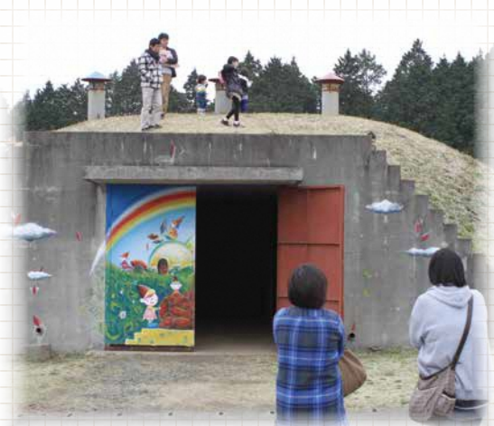
こびとの家(からいも貯蔵庫) 大津町次世代チャレンジプロジェクトより
