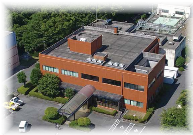
大津町浄化センター
