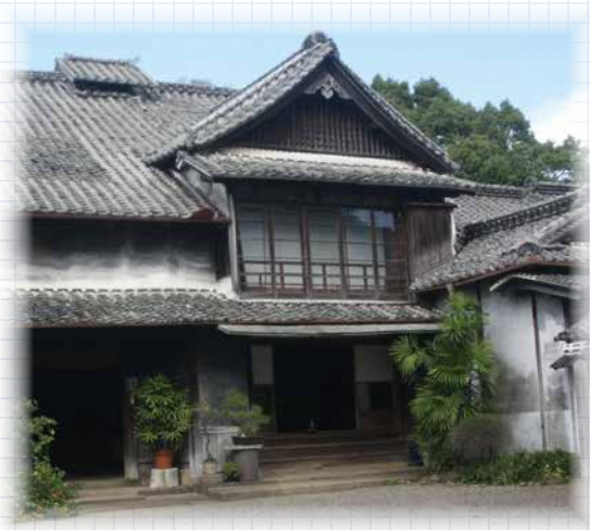
江藤家住宅(現在復旧工事中)
