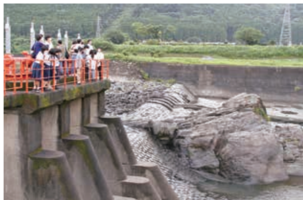
瀬田地区の下井手頭首工と兜岩を見る参加者
