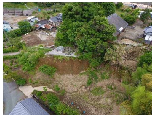
土砂災害対策予定箇所 （災害関連地域防災がけ崩れ対策事業）
