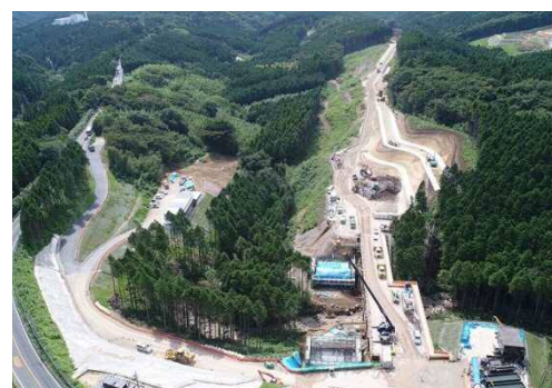
国道 57 号北側復旧ルート（大津側トンネル坑口付近）
