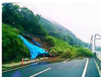
国道 57 号（応急復旧工事済）
