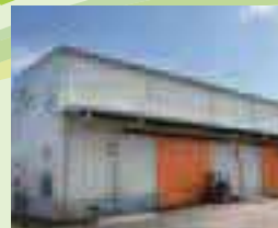
令和4年8月に操業開始した板金製缶の新工場
