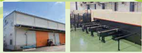
令和4年8月に操業開始した板金製缶の新工場 令和5年1月に導入3Dファイバーレーザー
