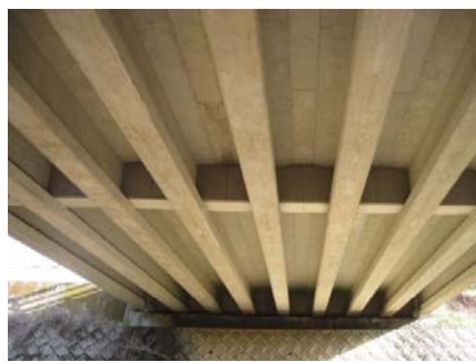
コンクリート橋
