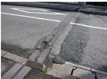
橋面：路面の凹凸，伸縮装置の欠損
