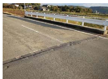
橋面：路面の凹凸，伸縮装置の欠損
