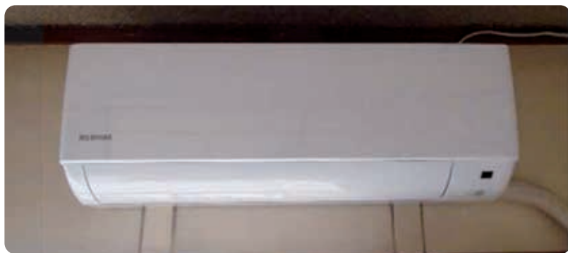
▲設置されたエアコン
