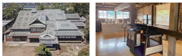
江藤家住宅 主屋 附小屋1階
