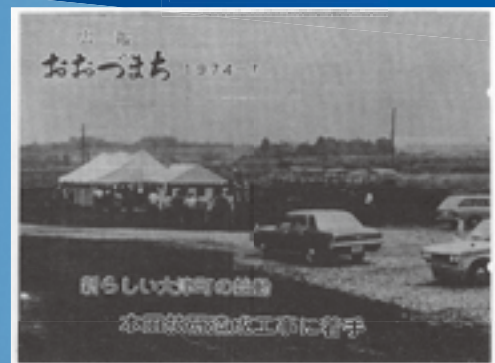
▲昭和49年(1974年)7月号 工事着手時の様子
