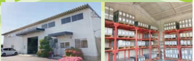
東熊本センター 事務所倉庫棟 (営業用倉庫登録済み)
