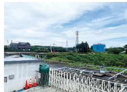
つつじ台区 汚水処理施設
