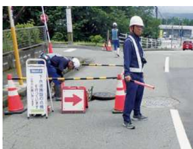
下水道の点検状況
