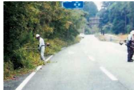
町道の除草作業
