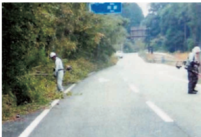
町道の除草作業
