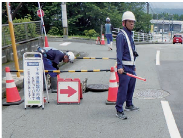
下水道の点検状況
