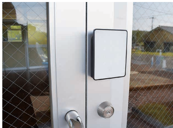
旧矢護川小体育館のリモートロック
