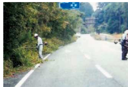
町道の除草作業
