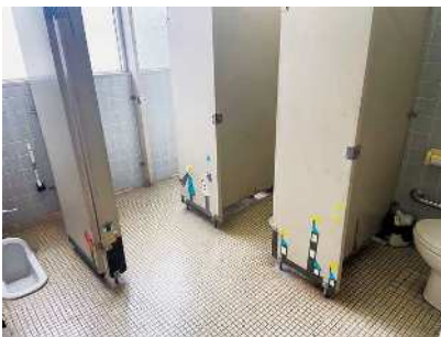
南小学校のトイレ
