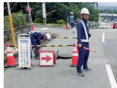
下水道の点検状況
