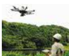
▲②ドローン（UAV）による測量
