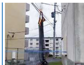
建設現場シート飛散による漏電火災
