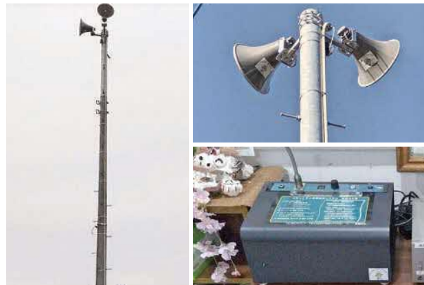
大津町森区の3カ所に設置されたコミュニティ無線放送システム
