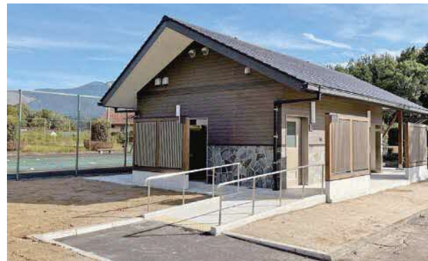
建物の一部に休憩スペースも設置してあります
