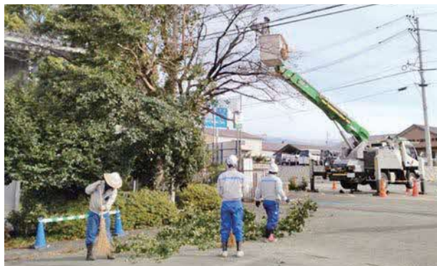
高所作業車を生かした剪定作業
