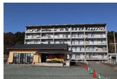
住棟南面・集会所
