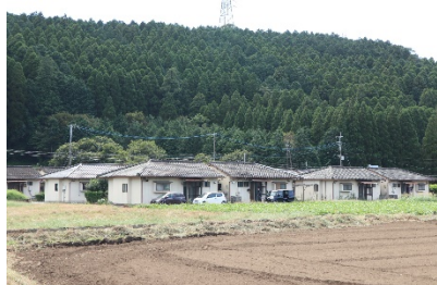
団地北側からの遠景
