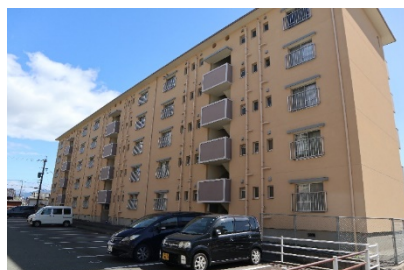
外壁改修済の住棟北面
