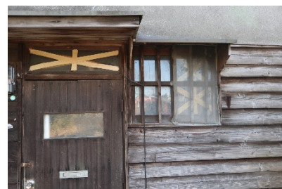
木製の玄関扉・外壁・窓格子
