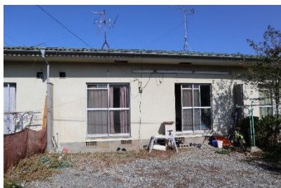
住棟南面(簡易耐火平屋建)
