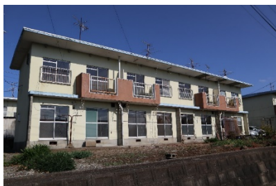
住棟南面(簡易耐火2階建)
