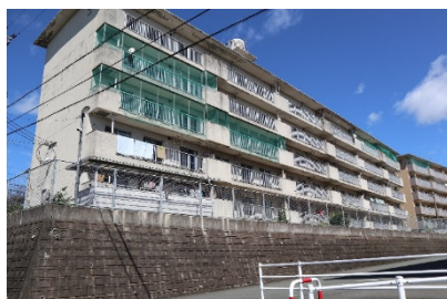
外壁未改修済住棟南面
