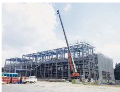
フェローテックグループの工場（建設中：杉水）
