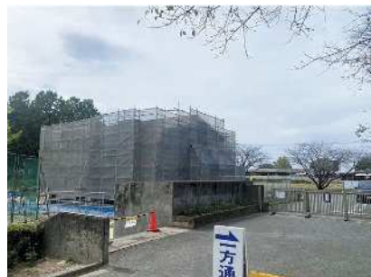
護川小に建設中の学童施設
