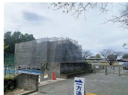
護川小に建設中の学童施設
