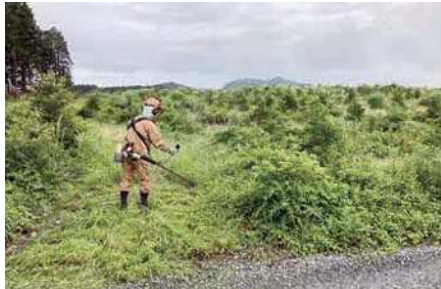
作業中の写真
