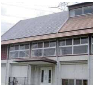
大津東小学校体育館屋根
