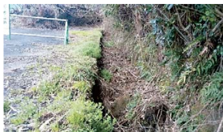
はか まき さかい め 外牧境目水路の崩落現場
