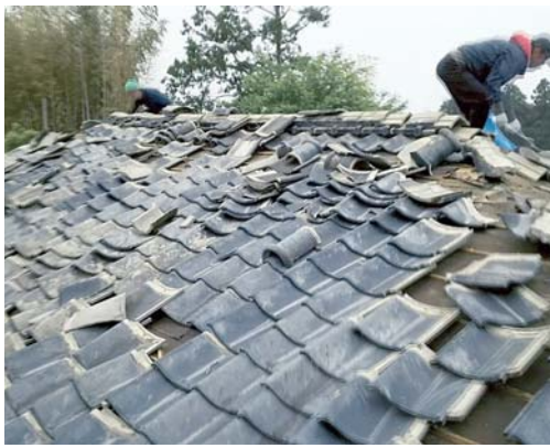
高尾野公民館 屋根瓦が崩落して雨漏り 宅地復旧と建物建て替えて約300万円の地元負担が発生する
