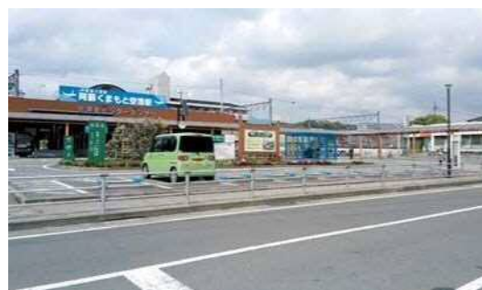
大津駅に新愛称（阿蘇くまもと空港駅）南側
