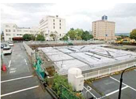
企業が建設中の保育施設
