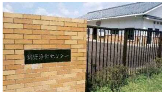
農業集落排水施設の錦野浄化センター
