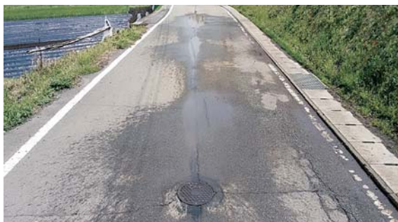
農村部でも下水道が整備されている町道
