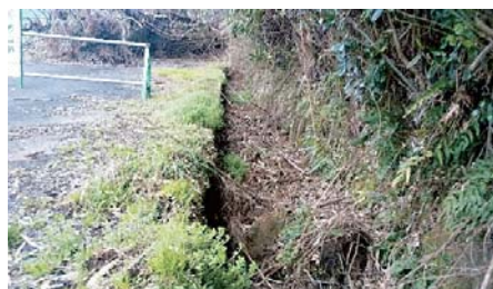
はか まき さかい め 外牧境目水路の崩落現場
