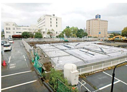
企業が建設中の保育施設
