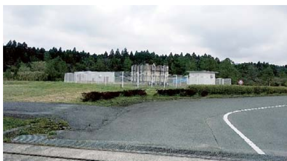
中核工業団地内の工業用水施設
