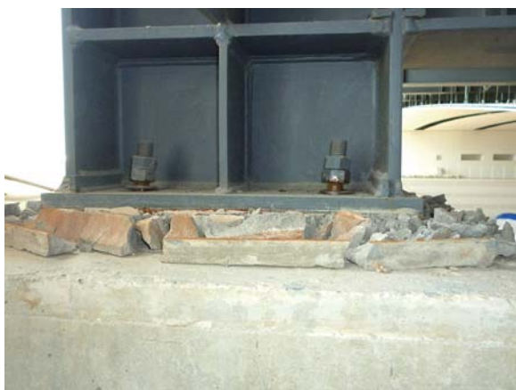
総合体育館メインアリーナの損傷 (壁と屋根を繋ぐボルトの破断)
