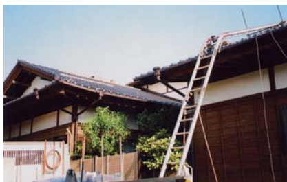
屋根の棟瓦修復
