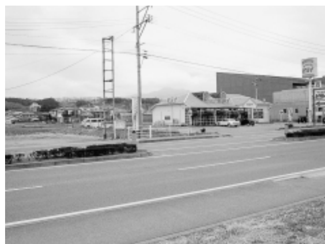
西鶴中井迫線交差点予定地付近
