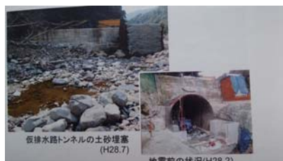
立野ダム仮排水路
