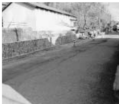
室塘町線の整備工事
