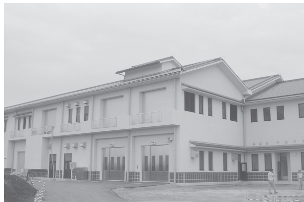
菊池広域連合立汚泥再生処理施設
