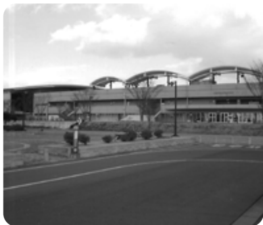
大津町運動公園球技場
