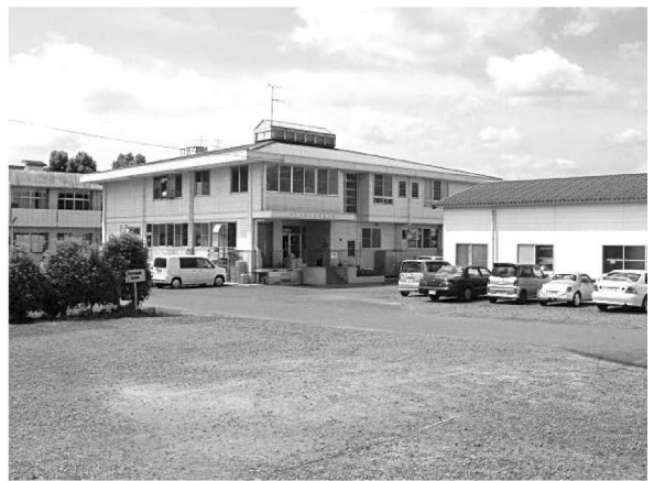
自立支援指導教室建設予定地（給食センター北側）
