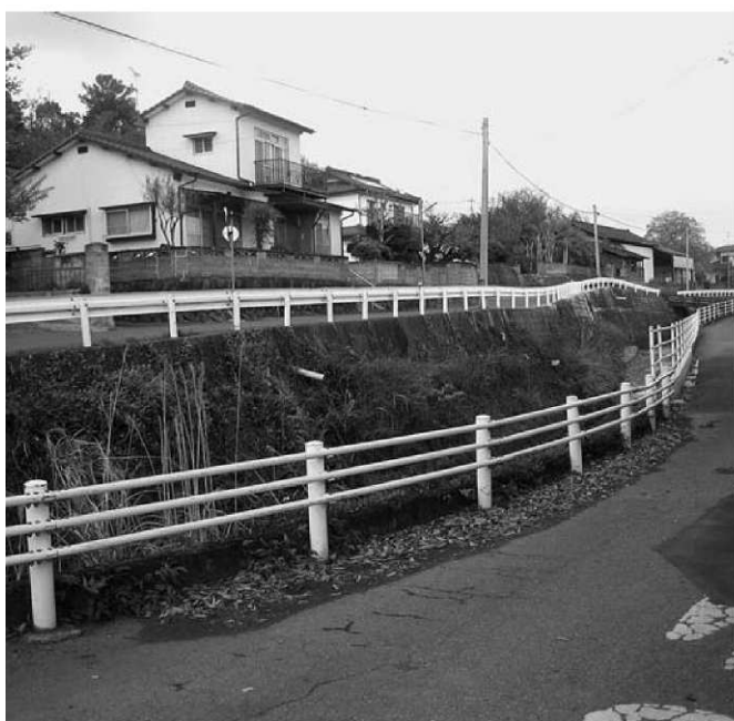
離合に苦労する上井手ぞい道路
